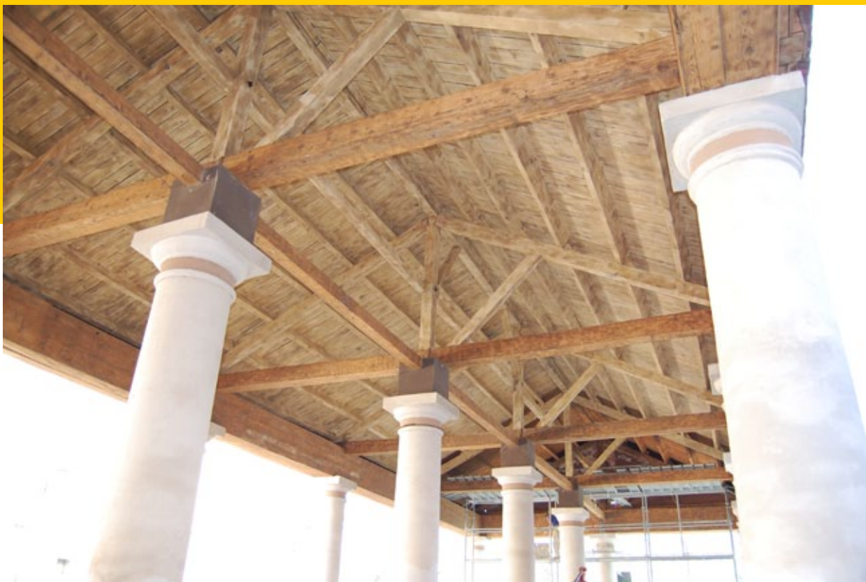
Restauration du Marché Couvert aux 21 colonnes classé Monument Historique
