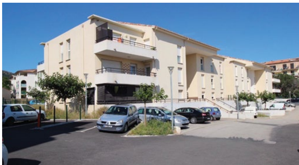
Construction de 24 logements sociaux
