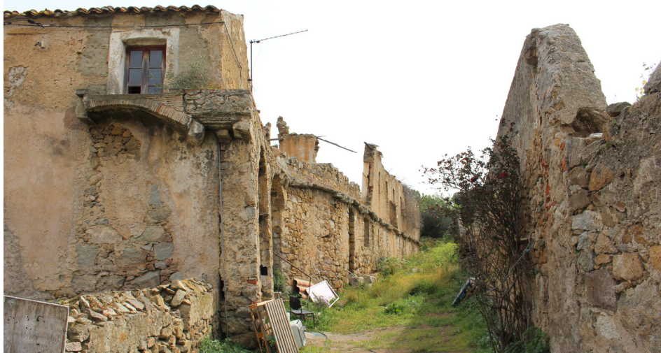
Fig. 24. L'ancienne tannerie qui s'intègre dans la topographie // photo du site
