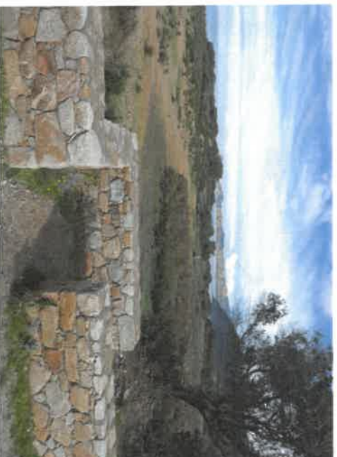
Muret en granit local appareillage de pierres de calibre varié pour la contention le long de la RD
