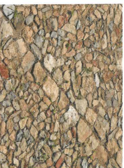
Calade structurée par des bandes de grosses pierres à un bord droit pour le parvis du phare
