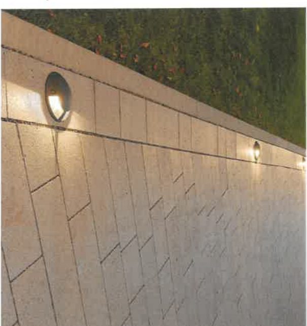
Luminaire à led encastré dans le sol (teinte brun-rouille) autorisant le roulement, éclairage rasant pour le balisage lumineux discret du chemin du phare
