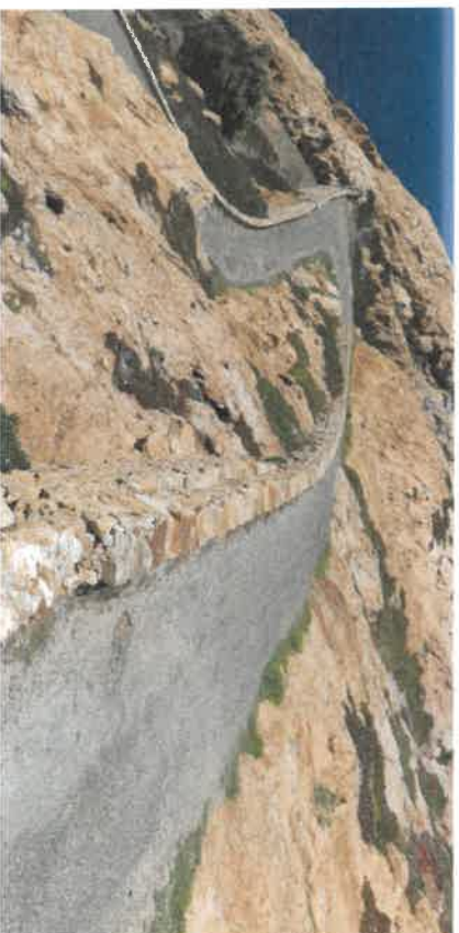
2. La route, son tracé sinueux, épousant les formes du relief, ses murets
